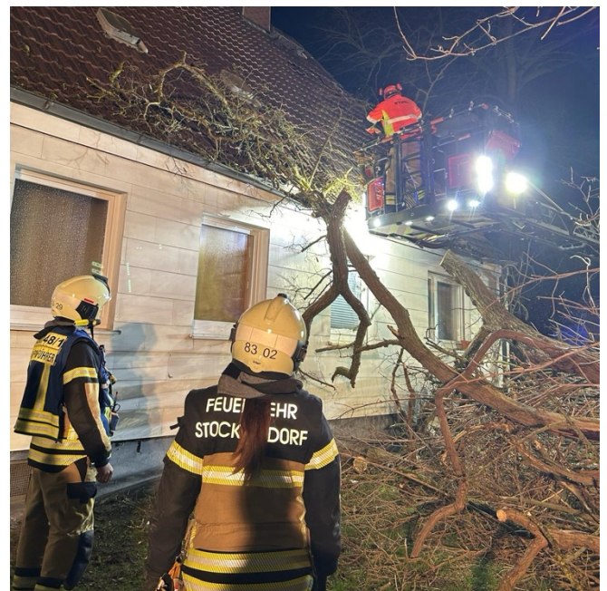
Technische Hilfe im Januar: Ein Baum war auf ein Gebäude gestürzt
